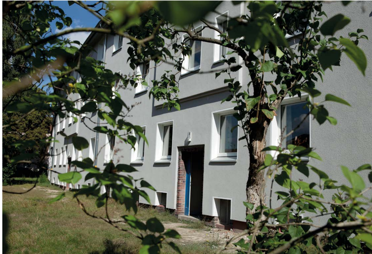
Hier befinden sich die Appartements des Wohnangebots Walkürenring in Braunschweig.
